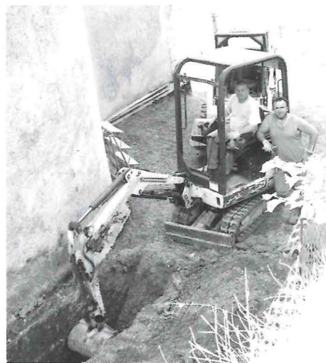
Alcuni operai presenti sul cantiere
