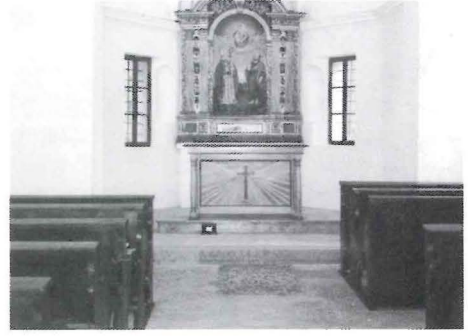
Scorcio del pavimento in battuto di calce
