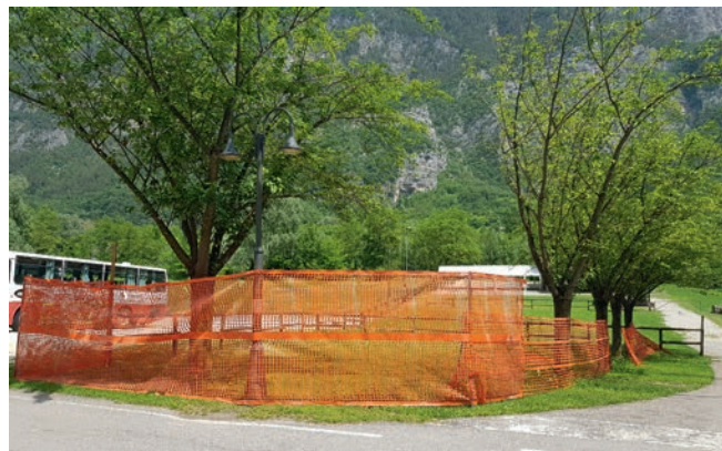
Il cantiere del nuovo parco giochi
