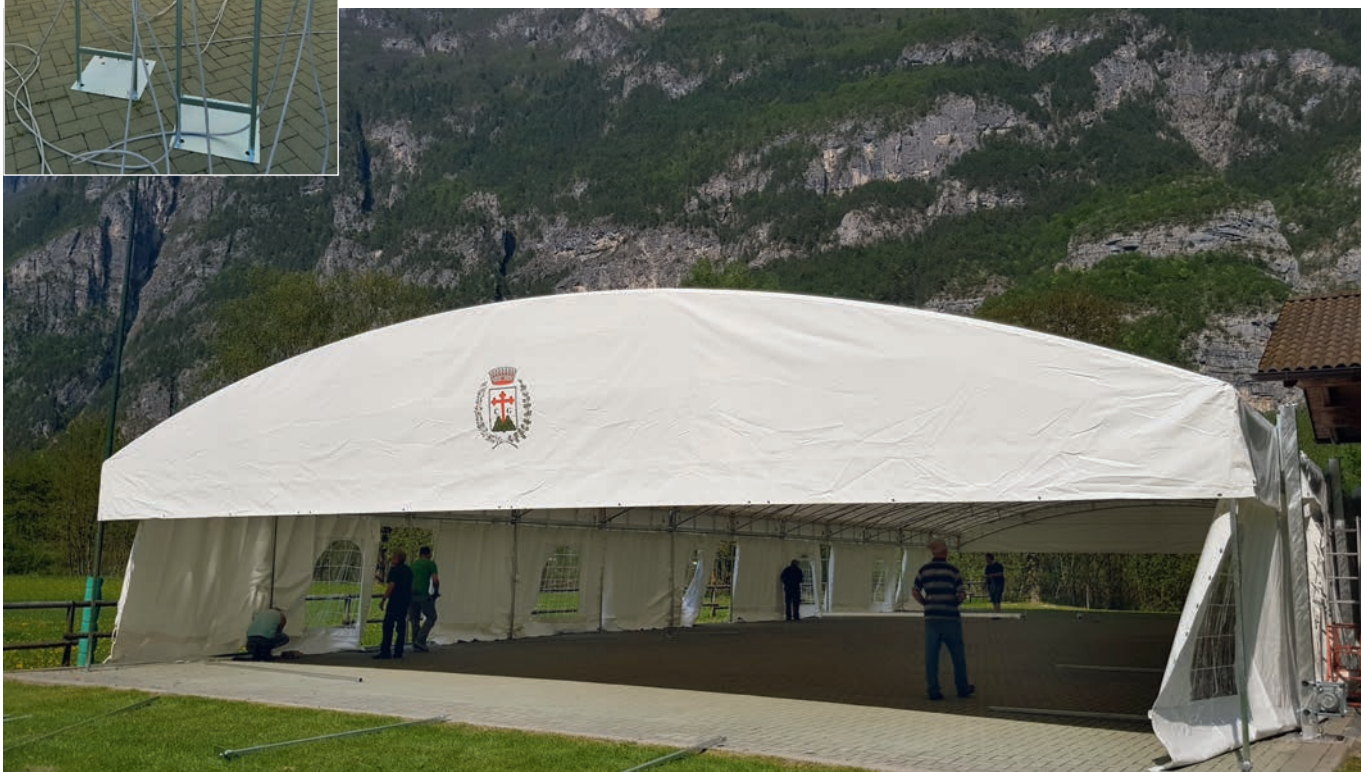
Nelle immagini, la nuova tensostruttura comunale
