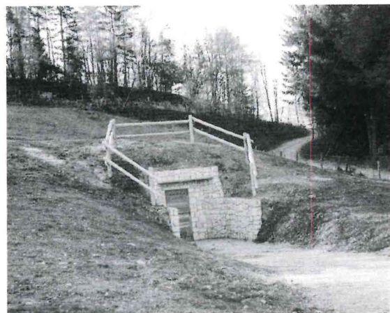
Nuovo bacino: lavori finiti
