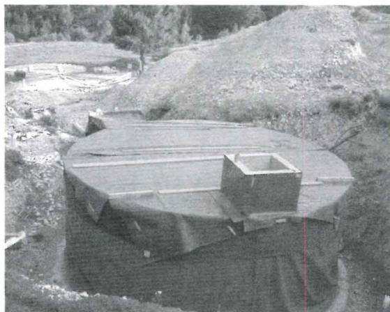
Nuovo bacino: cantiere aperto
