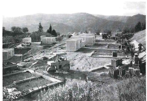
Uno scorcio del cantiere "Giove di Valtopina"
