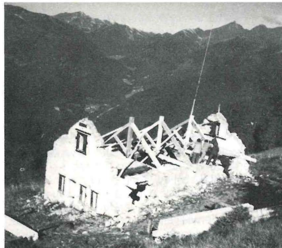
La «Casera» in ristrutturazione.
