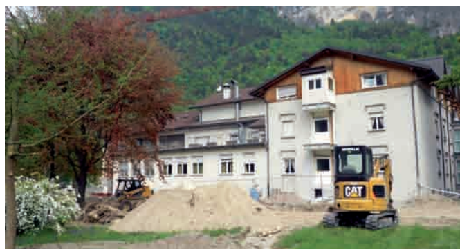
Grigno, i lavori alla casa di riposo
