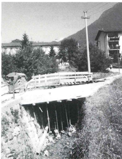
Il ponte verso Le Gescal (Foto Fedrizzi).
