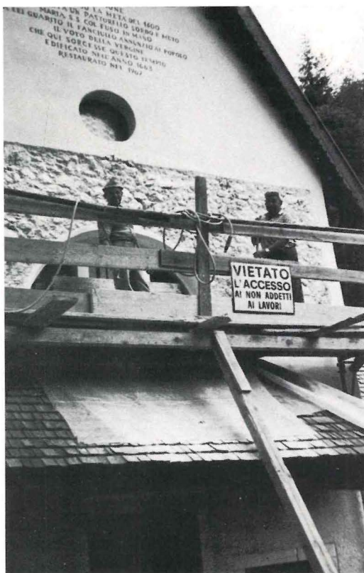
Lavori al santuario.
