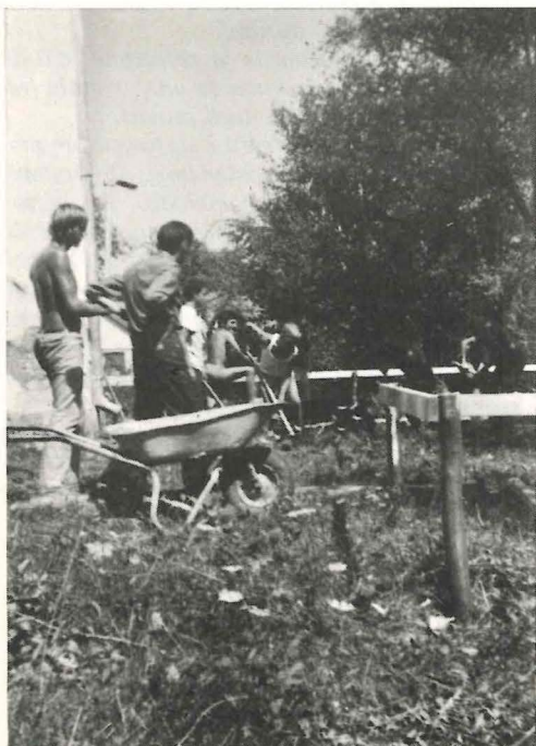
Stivor: lavori per la chiesa
