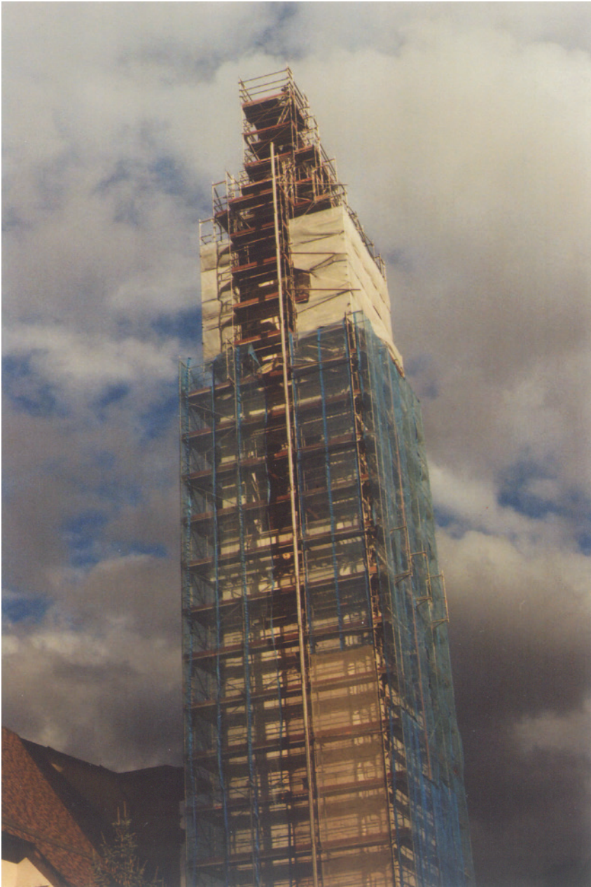
Restauro del campanile (2013): Foto G. Candotti.
