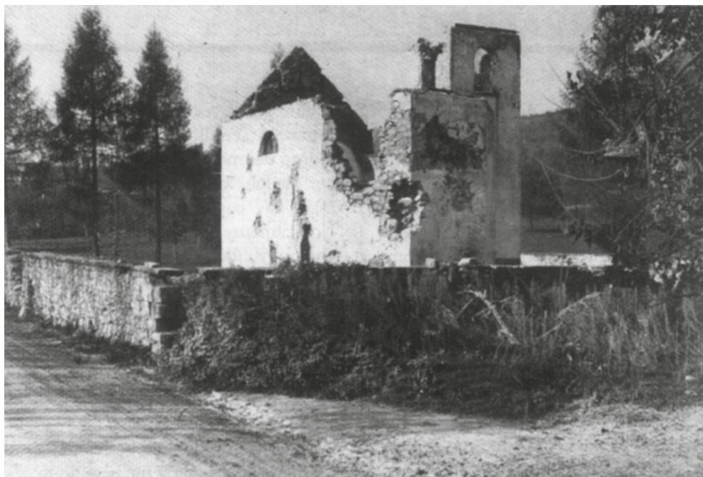
La chiesa cimiteriale di S. Daniele distrutta dai cannoneggiamenti del 1916. Foto: da Voci Amiche.
