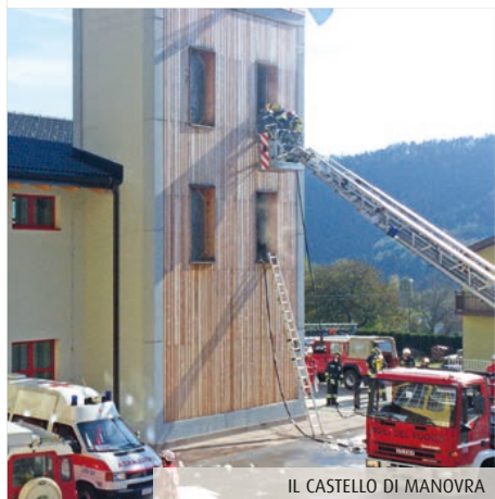
IL CASTELLO DI MANOVRA
