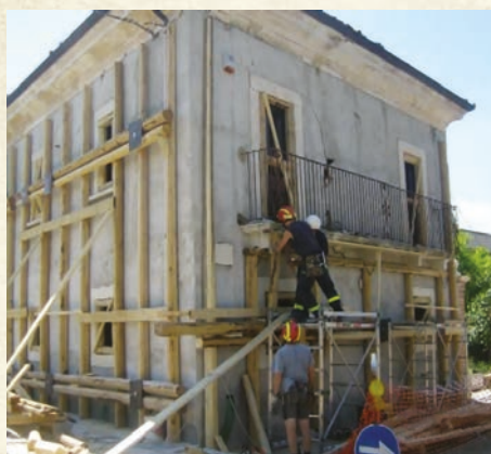
2009. Terremoto Abruzzo. I lavori di puntellamento e consolidamento ad Onna. Nella foto centrale Daniel Campestrin e Giuliano Campestrin.
