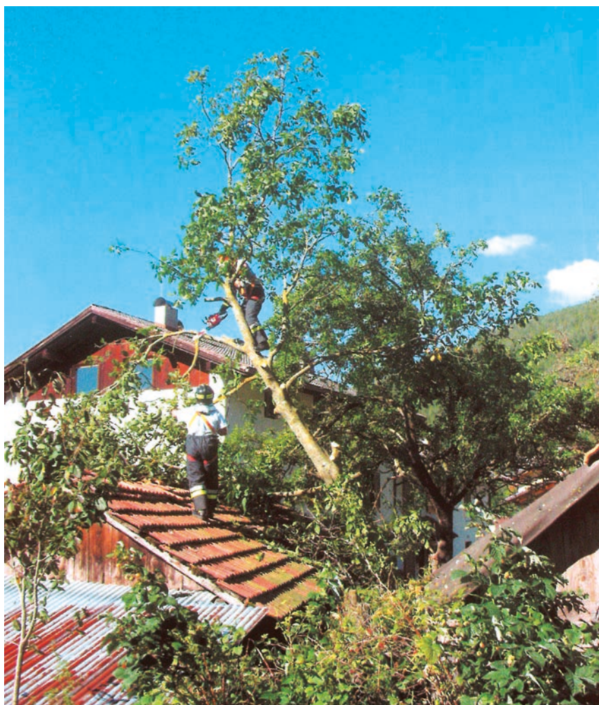
2007. Intervento per piante abbattute dal vento.
