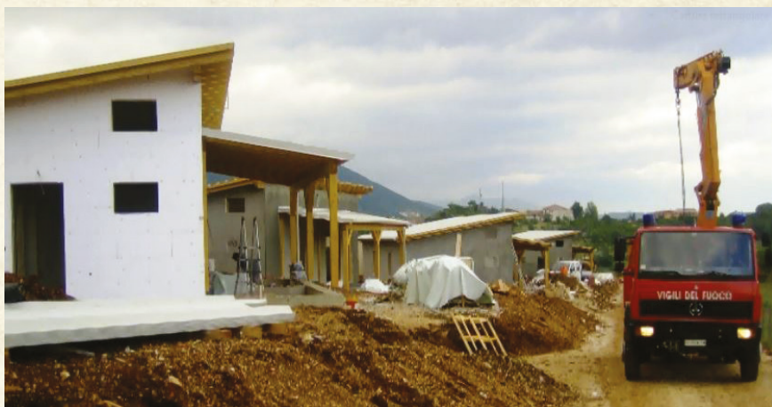
2009. Terremoto Abruzzo. Il montaggio delle case prefabbricate.
