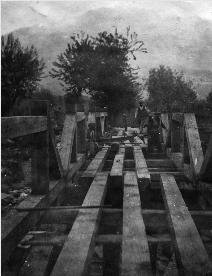
Castelnuovo, realizzazione del ponte delle "Spagolle" (foto gentilmente messa a disposizione da Giuliana Dalla Rosa).
