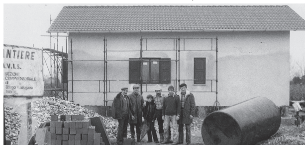
Friuli 1976 - cantiere A.V.I.S.
