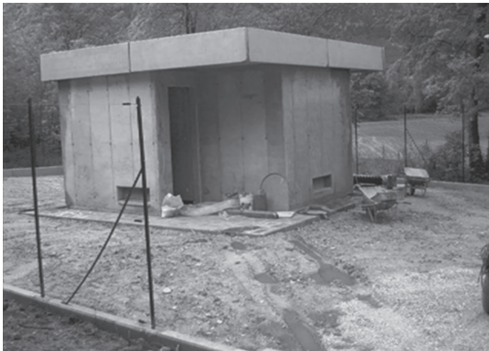
Il nuovo pozzo artesiano
