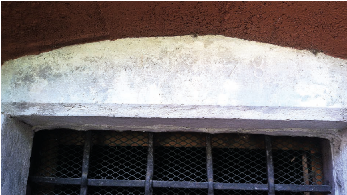
Particolare di casa Peloso, 1578
