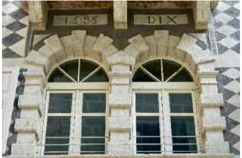
Un suggestivo dettaglio della facciata restaurata del palazzo Fusio Limana
