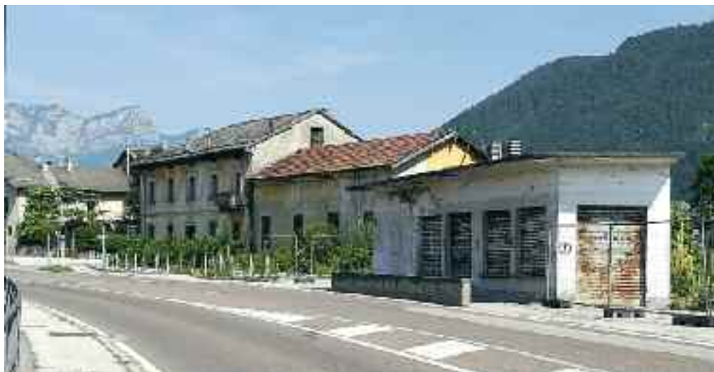
Lo stato di abbandono di alcuni stabili in prossimità del semaforo per la Val di Sella
