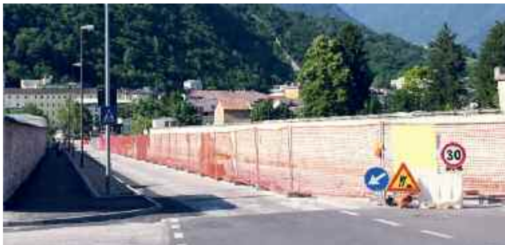
L'attuale stato dei lavori lungo via Temanza
