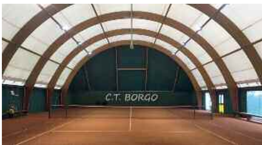
L'impianto coperto del CT Borgo
