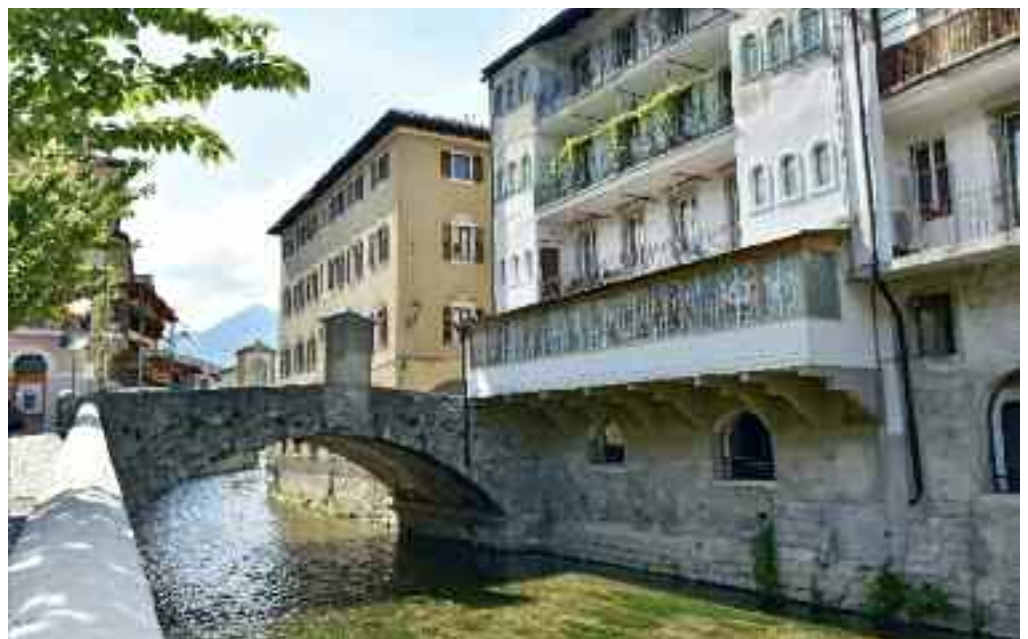
Il ponte veneziano a Borgo
