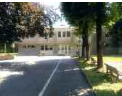
Sopra: l'ex caserma dei Vigili del Fuoco in via per Olle; sotto: la prossima sede dell'INPS in via della Fossa nello stabile già occupato in precedenza dal Giudice di Pace
