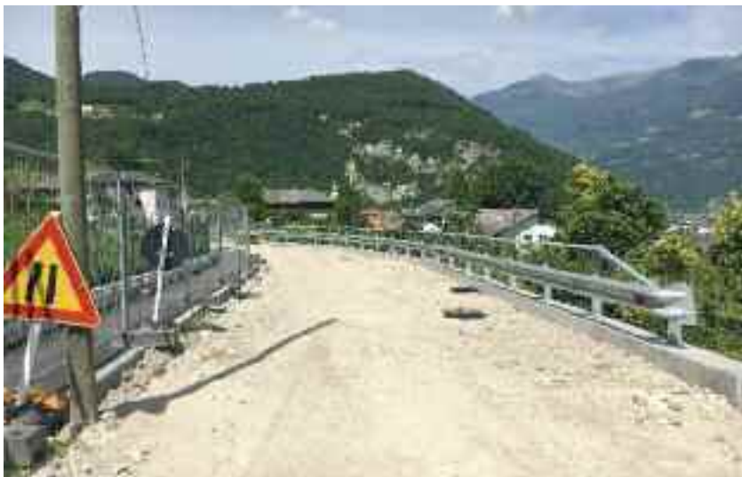
Il cantiere in opera su via Pozzi a Olle
