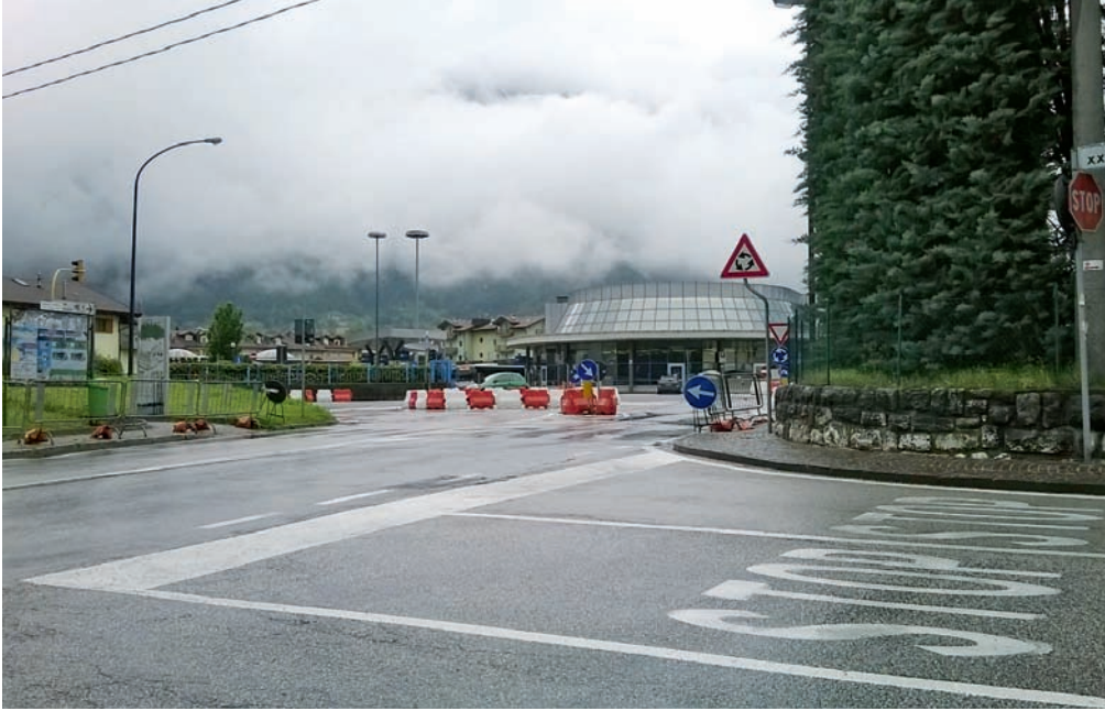
La sistemazione temporanea della rotatoria davanti al Centro intermodale di Borgo
