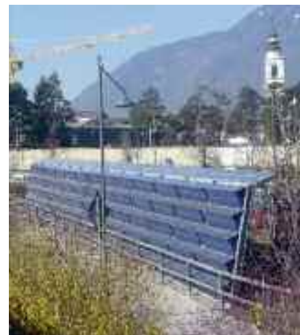
I pannelli che ospitano il sistema di rilevamento del traffico lungo la S.P. 109 che attraversa Borgo
