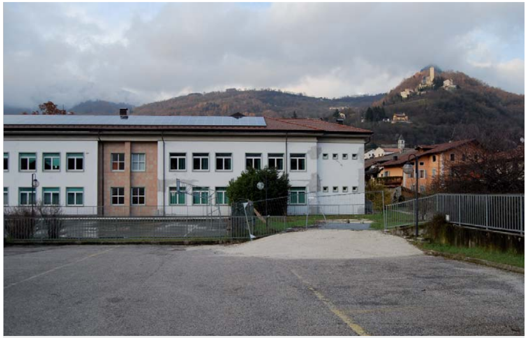
La Scuola media "Ora e Veglia" di Borgo, con l'accesso al cantiere da sud
