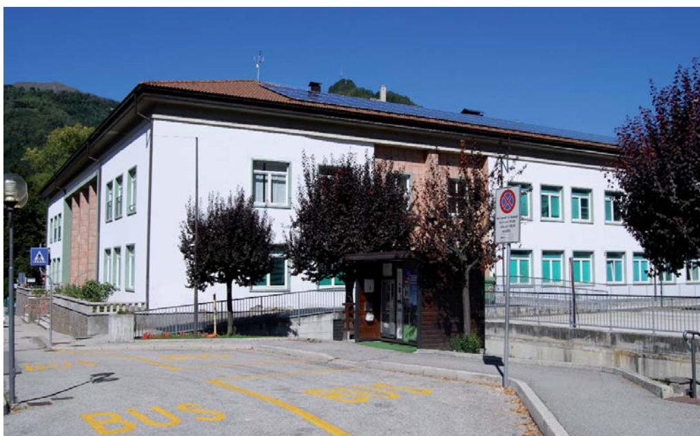
Una vista dello stabile che ospita la Scuola media di Borgo, oggetto di una serie piuttosto robusta di interventi che hanno restituito ad alunni e docenti una struttura più sicura ed accogliente
