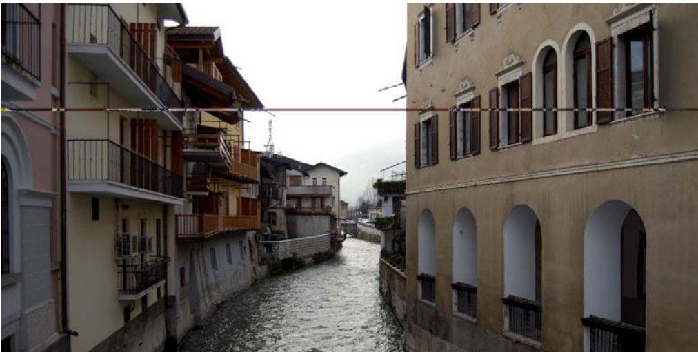
Il fiume Brenta a Borgo; gli insediamenti civili e commerciali a ridosso del corso d'acqua richiedono la massima attenzione per evitare disastri in caso di eventi alluvionali, ma i loro proprietari devono anche essere messi nelle condizioni di poter sviluppare al meglio le loro attività, anche ristrutturando e modernizzando gli stabili che guardano sul fiume
