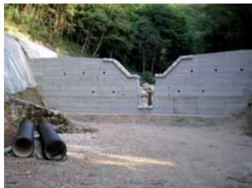
La nuova briglia filtrante realizzata sul Secondo Boale
