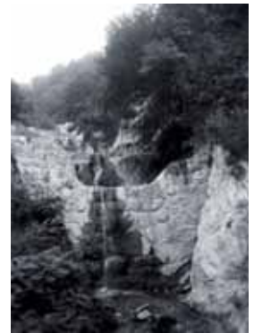
Acqua che scorre nel "boale": un evento sempre meno frequente e, dopo gli ultimi interventi di bonifica, ora sotto controllo
