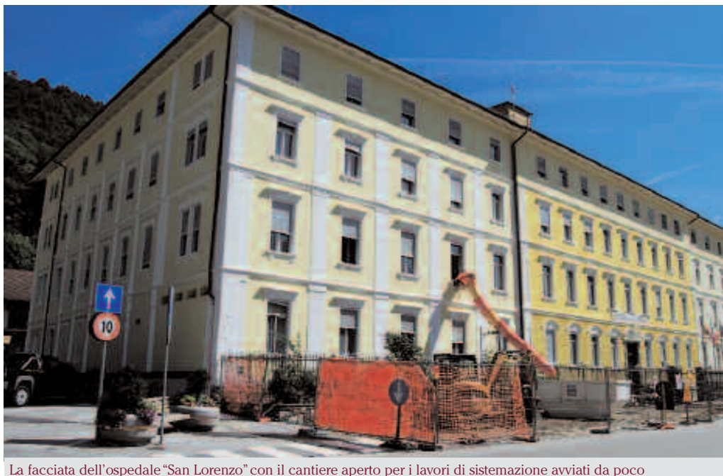
La facciata dell'ospedale “San Lorenzo” con il cantiere aperto per i lavori di sistemazione avviati da poco
