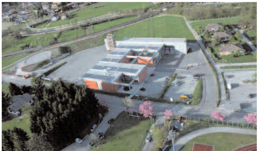
I pannelli fotovoltaici ben visibili sul tetto della nuova sede della Protezione Civile (foto Massimo Luzzana)
