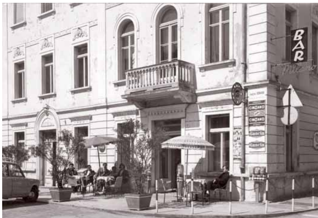
Il Bar Milano di un tempo con l'evidente richiamo (in alto a destra) al servizio telefonico pubblico offerto dal locale
