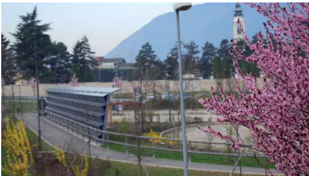
Un totale della barriera antirumore con pannelli fotovoltaici ben integrata anche con la... fioritura primaverile
