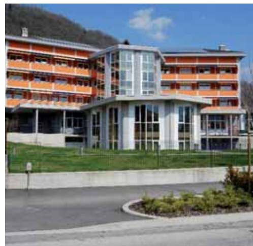
Lavori quasi completati alla casa di riposo di Borgo
