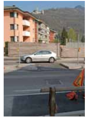
I lavori in corso per la realizzazione del passaggio pedonale nei pressi della stazione
