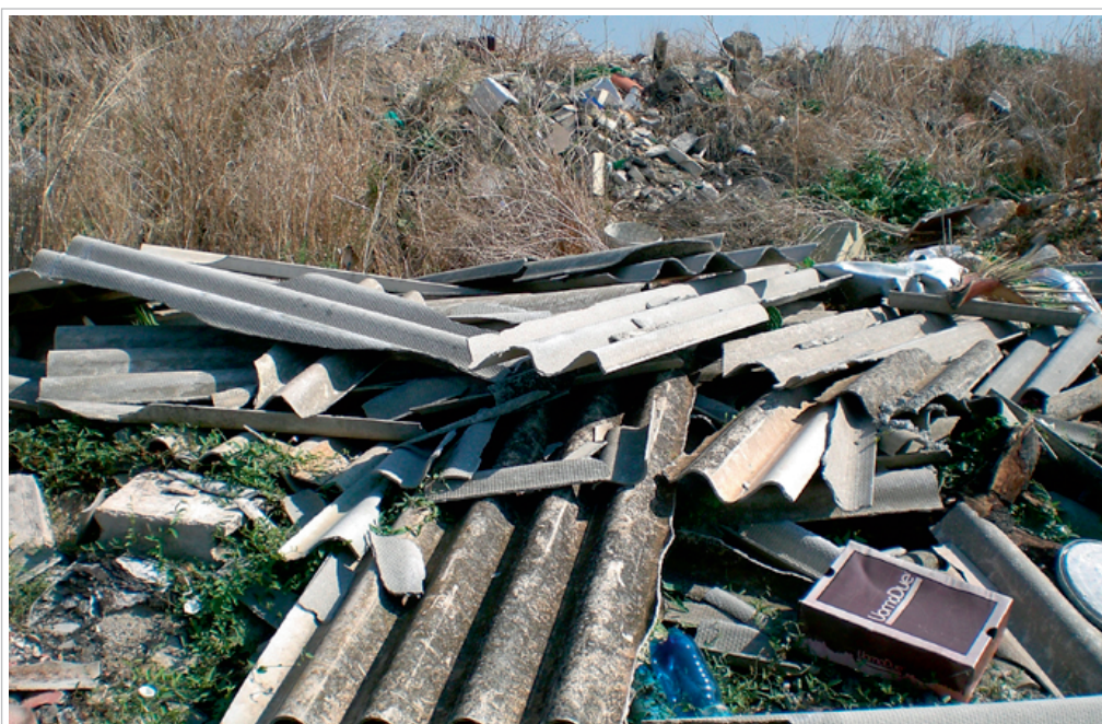
Materiale in eternit abbandonato in una discarica non autorizzata. Al danno ambientale si aggiunge anche quello, forse più grave, che manufatti di questo tipo possono arrecare alla salute dei cittadini
