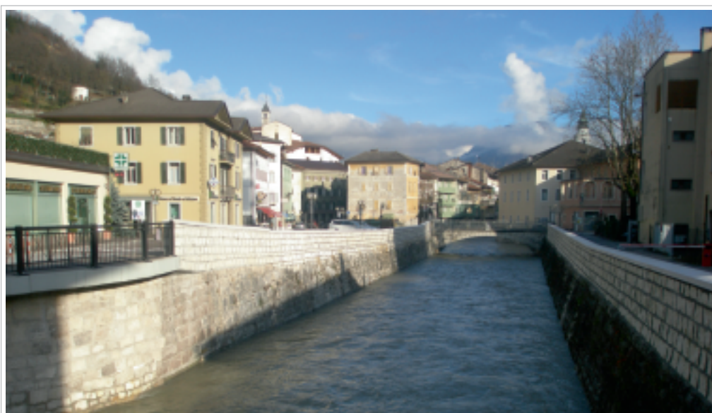
I nuovi parapetti lungo gli argini del Brenta nel centro del paese
