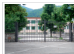
La scuola elementare di Borgo che in un prossimo futuro potrebbe essere abbattuta
