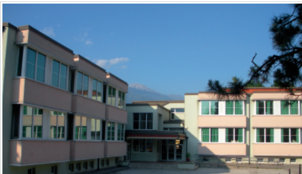
Il piazzale d'ingresso dell'attuale sede della scuola elementare di Borgo Valsugana
