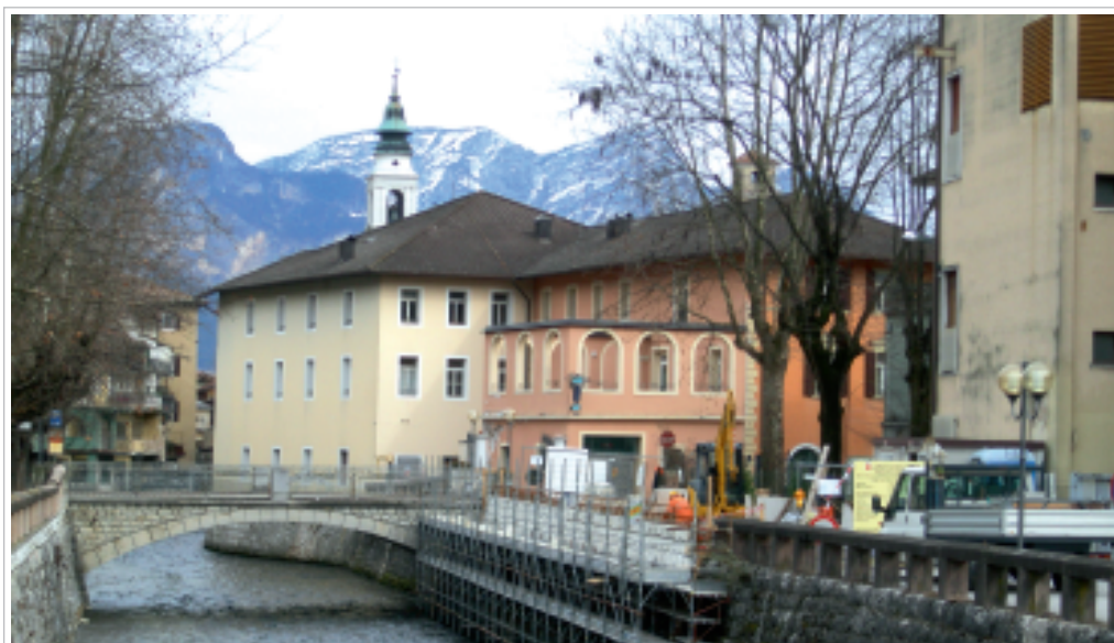
Uno dei cantieri aperti lungo il Brenta nei pressi dell'ufficio postale
