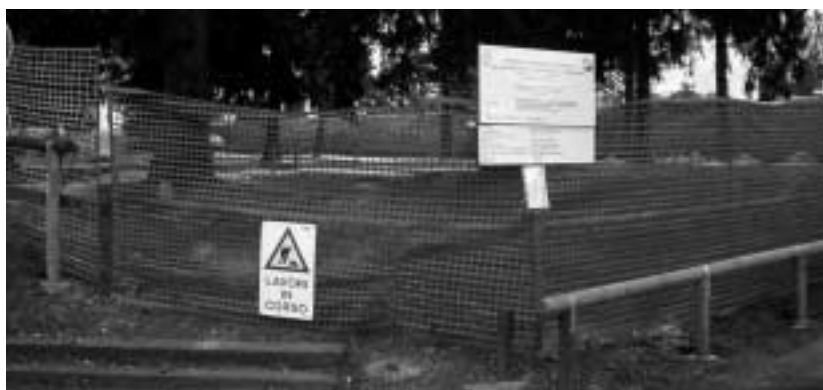
Il cantiere per la nuova area per la sosta dei camper lungo la via Temanza
