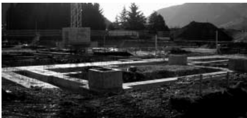
I lavori per il nuovo Centro di protezione civile
