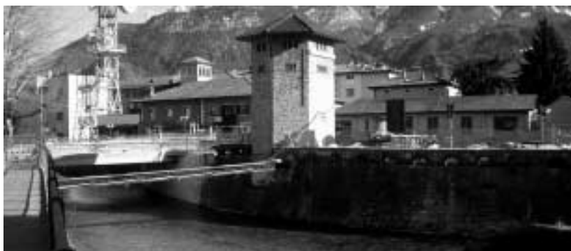
I lavori per la realizzazione del nuovo ponte nel centro storico di Borgo
