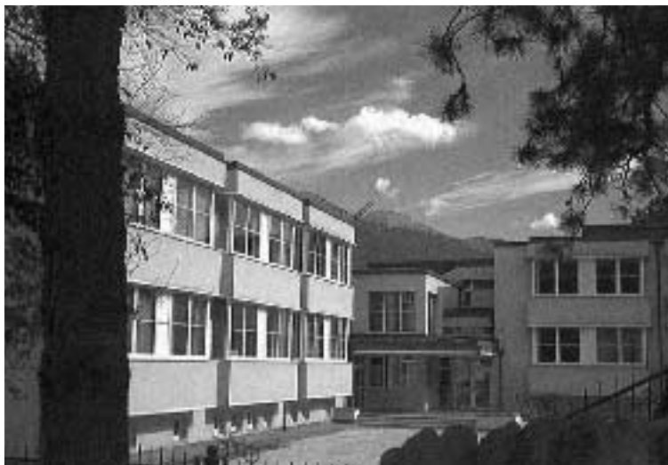
La scuola elementare i cui lavori di ampliamento costeranno circa 6 milioni di euro
