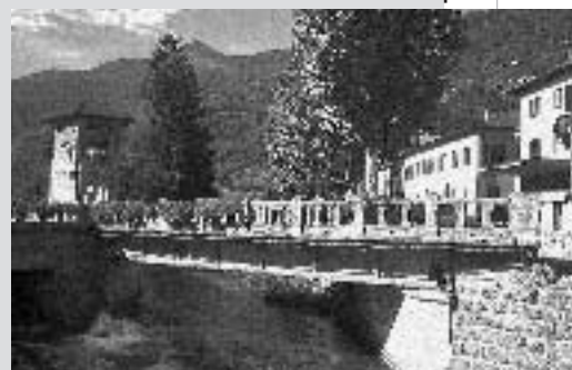
Il ponte di viale Roma che dovrà essere sistemato
