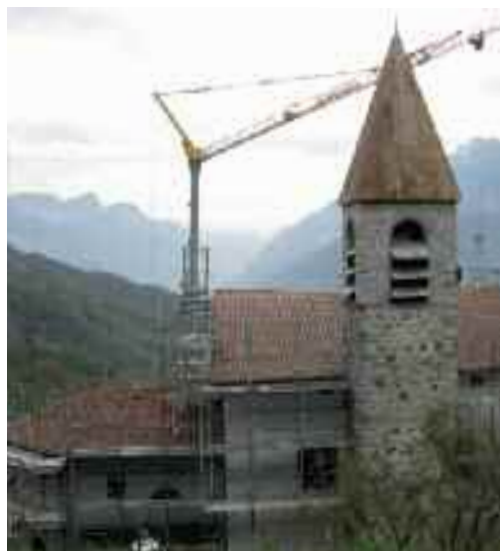
Una fase dei lavori del tetto della chiesa
