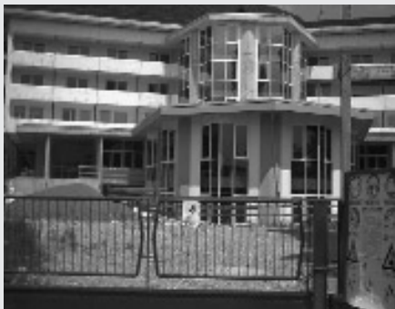
Il cantiere dei lavori alla Casa di Riposo di Borgo
