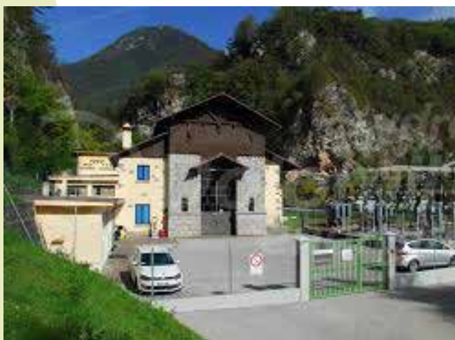
Centrale di Carzano
