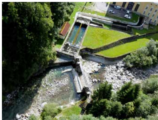
Centrale di San Silvestro - vista aerea dell'opera di presa sul torrente Vanoi
