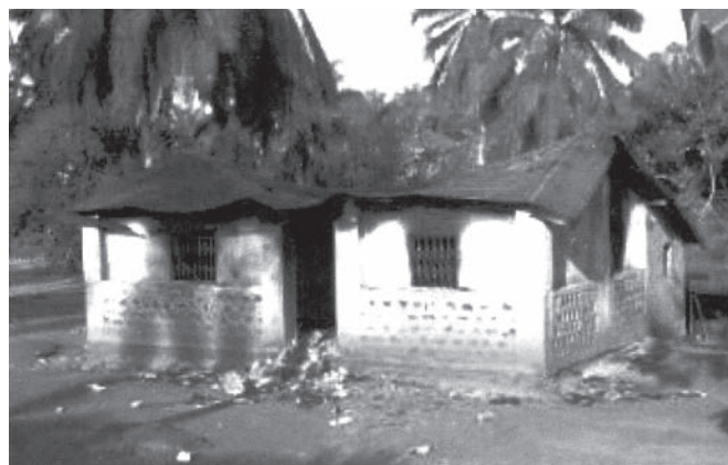
Edificio della missione distrutto
