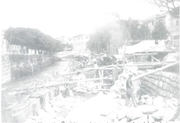
Lavori del 3510072 - Demolizione del vecchio argine, al ponte dello stradoro
