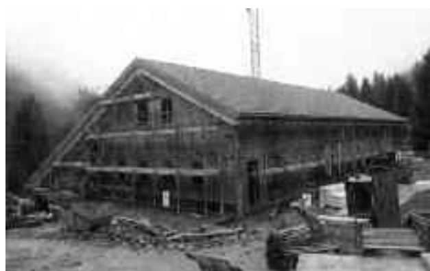
Zona centrale copertura dell'edificio e inizio rivestimento in pietra
