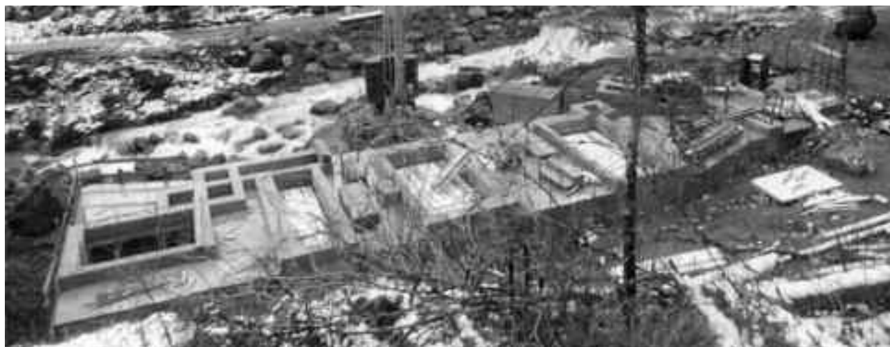
Presa di Calamento - completamento del solaio e ripristino argini
