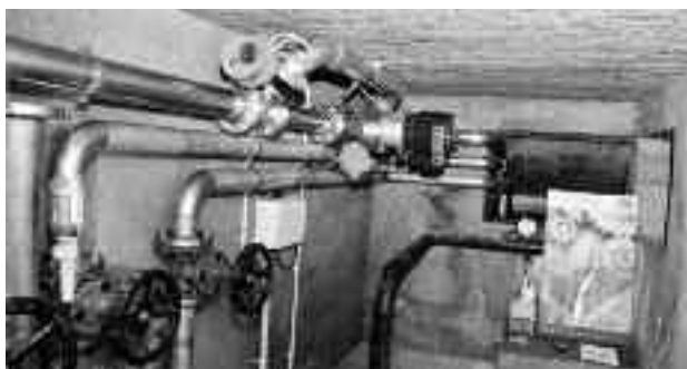
Installazione turbina che consente di ricavare energia elettrica attraverso una macchina posizionata all'interno di tubi in pressione
