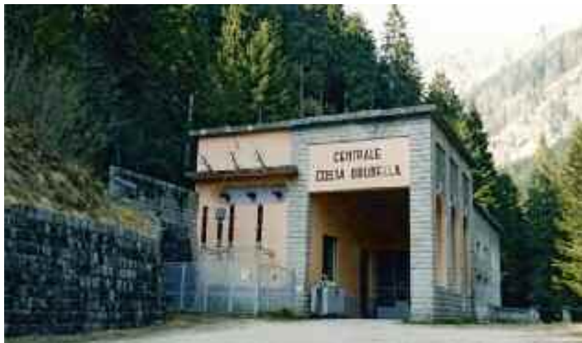
La Centrale di Costabrunella
