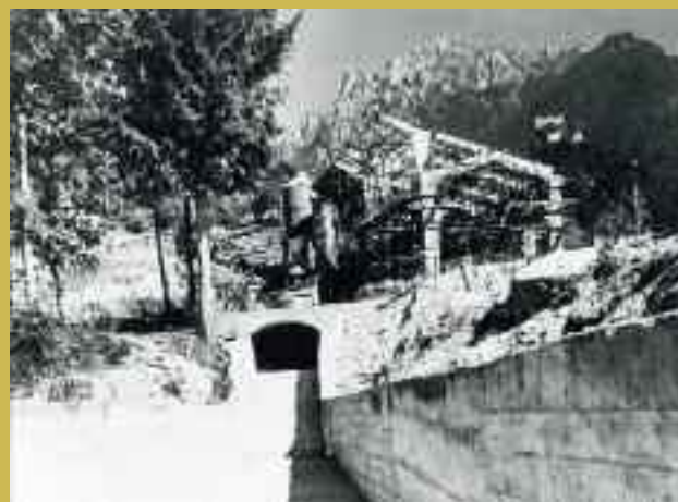
La centrale di Castelpietra [archivio gruppo ACSM Spa]
