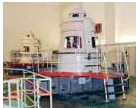
Dall'alto: la diga di Arsié e l'impianto di Cavilla
