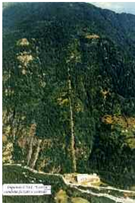
A lato gli interni della centrale di Caoria, in alto la condotta della centrale idroelettrica ed un'immagine dall'alto dell'impianto di Caoria
