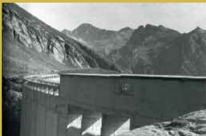
La centrale di Costabrunella
