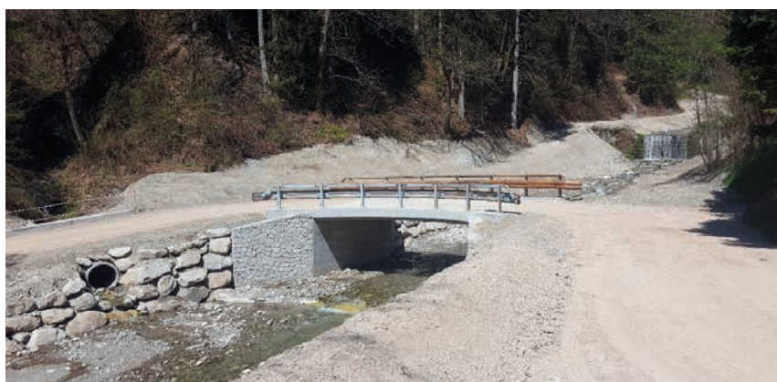
Rifacimento ponte Rio Lusumina - dopo
