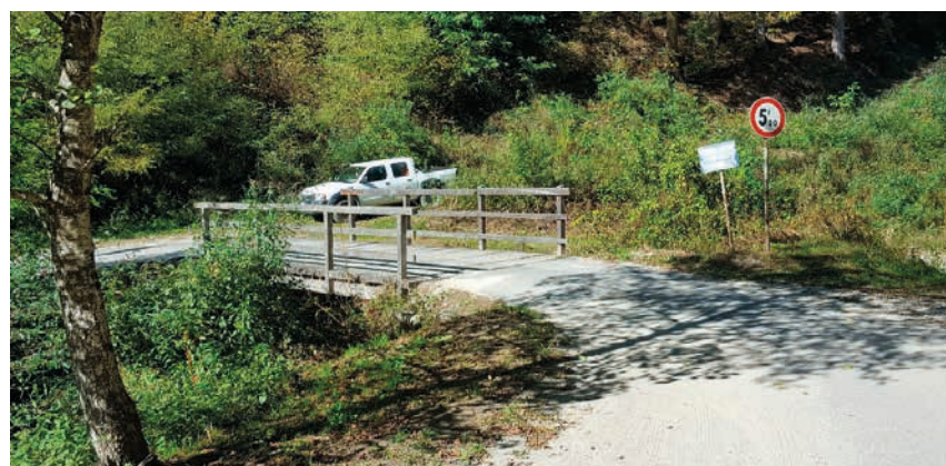
Rifacimento ponte Rio Lusumina - prima
