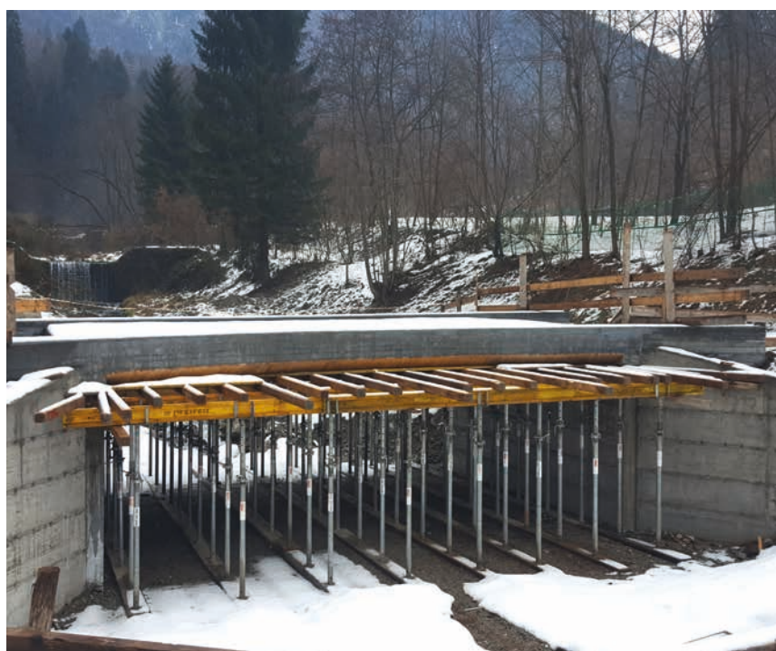
I lavori di rifacimento del ponte sul Rio Lusumina
