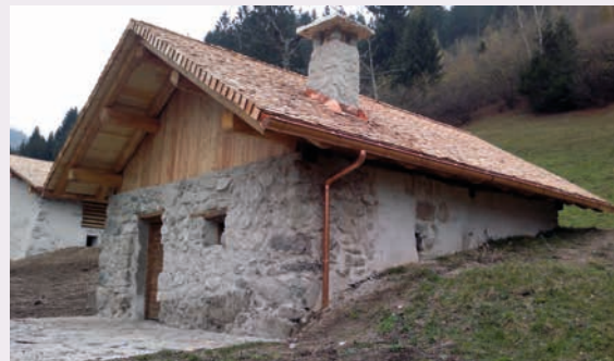
Vista edificio di servizio
