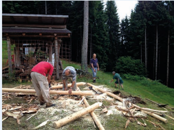
Lavori per la nuova staccionata
