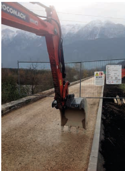
I lavori di realizzazione della pista ciclabile
