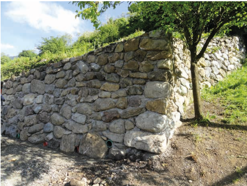
Il muro dopo l'intervento di sistemazione
