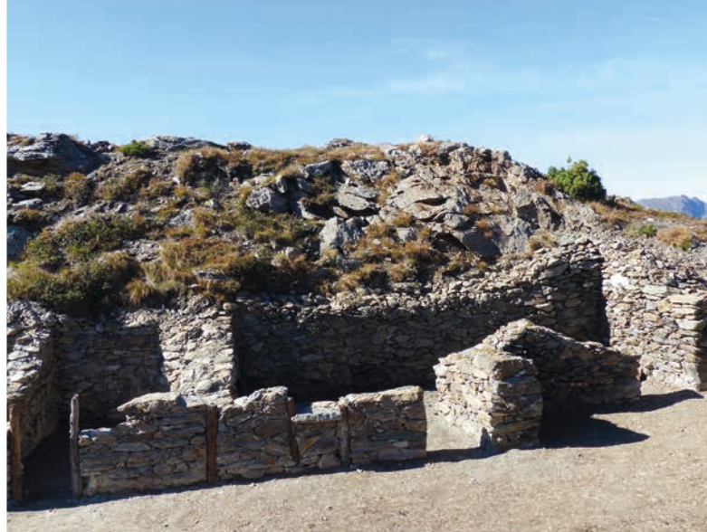
Dopo il ripristino
