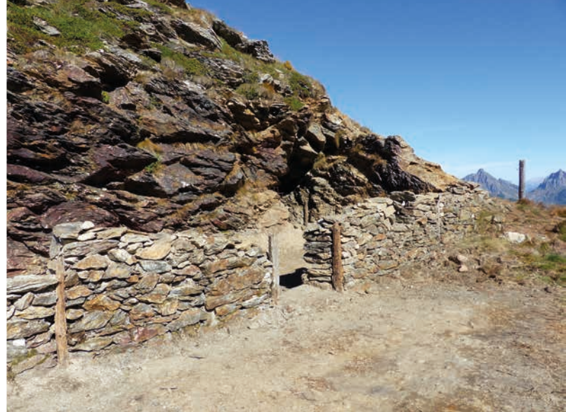
Dopo il ripristino
