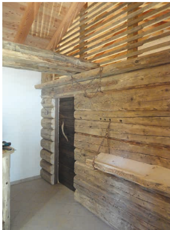
Lavori interni baita comunale
