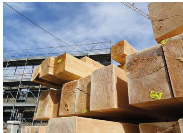
5 - Arrivo in cantiere
