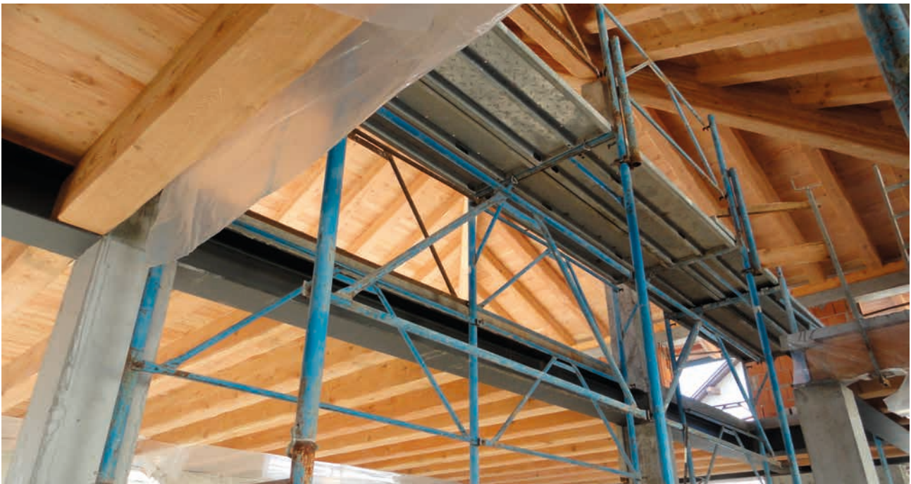
7 - Solaio e tetto in larice
