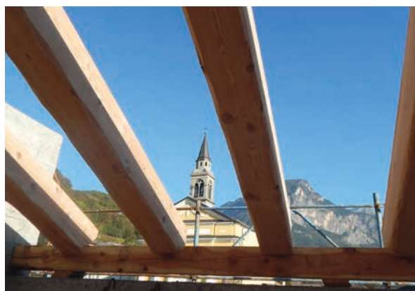
6 - Posa del tetto
