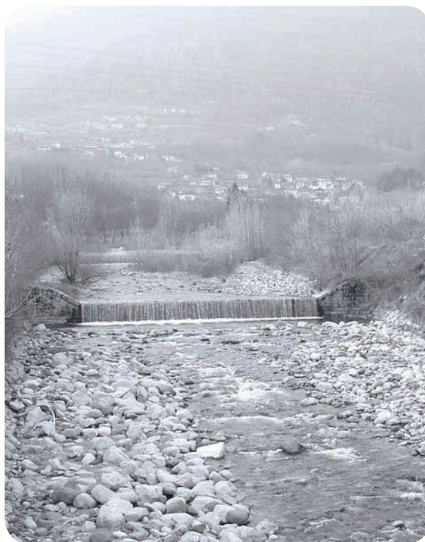
il torrente Maso
