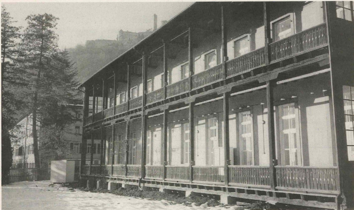
Il prospetto sud dell'ex sanatorio allo stato attuale
