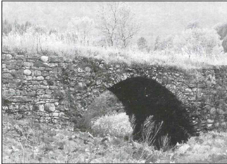
Ponte romano a Castello Tesino
