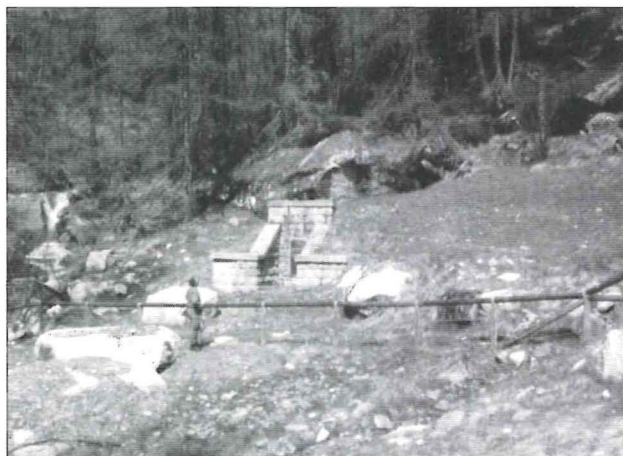
L'opera di presa di Rava
