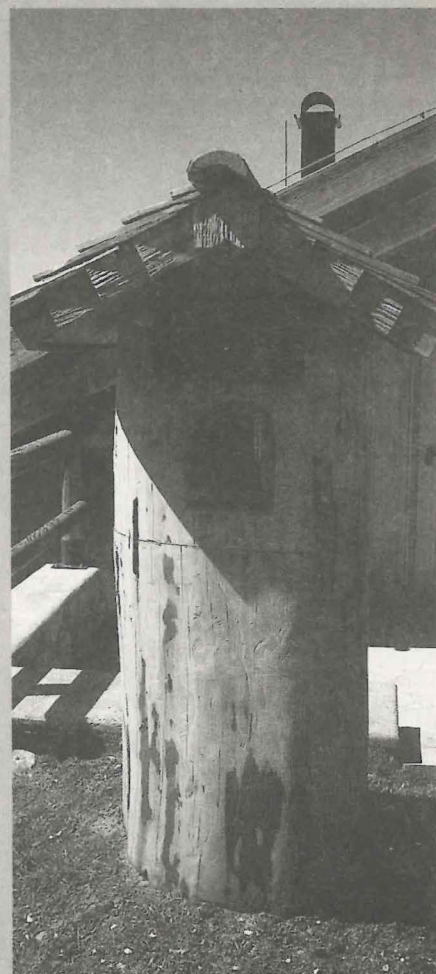
Il camino di sfiato realizzato dai volontari presso la Casa Vacanze.
