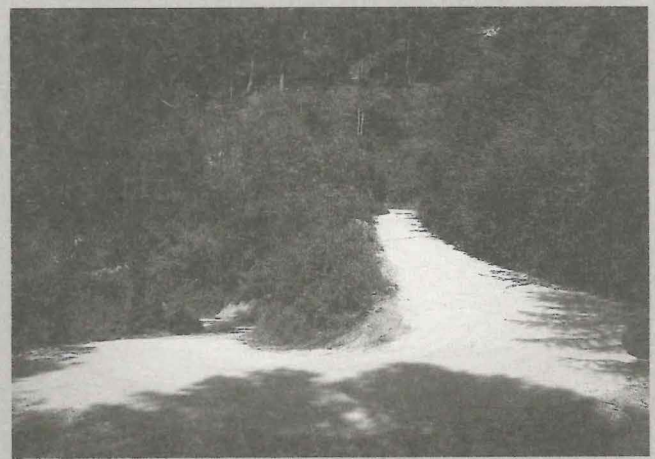
Cementificazione di tornanti sulla strada per Primaluna.
