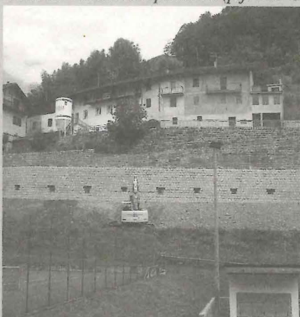
I lavori di somma urgenza e di realizzazione del paramento in pietra sull'ultimo tratto di via Santa Apollonia (p.f. 723 CC Spera I).
