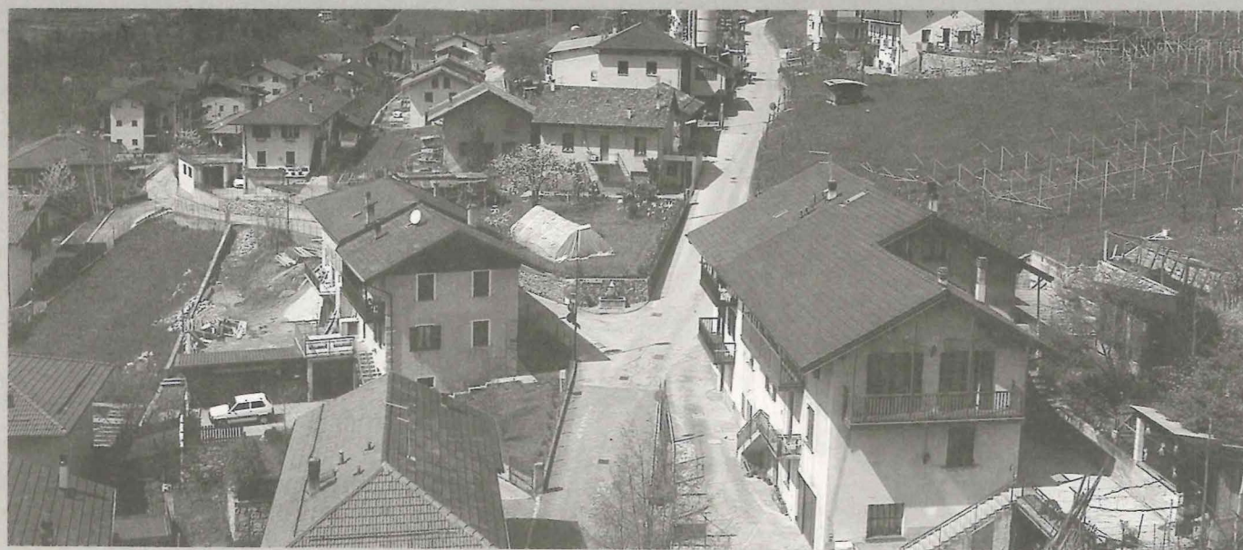
Via Cenone: in progetto l'allargamento e la messa in sicurezza.
