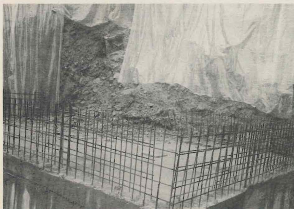
Vasca in costruzione dove verrà montata la centralina idroelettrica
