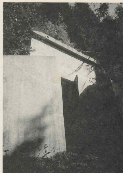
Esterno opera presa Maseron (Rava Nuova)
