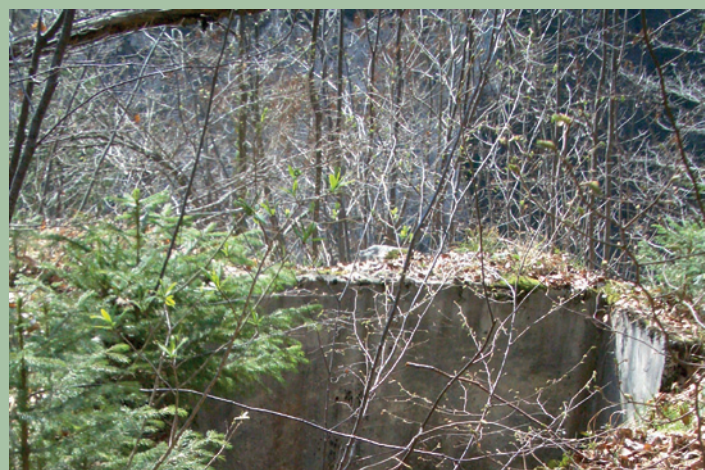
Interno centralina con tubo il legno
