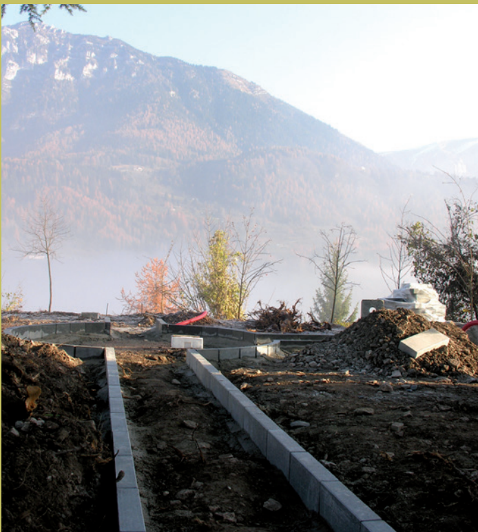
Lavori in corso a San Polo.
