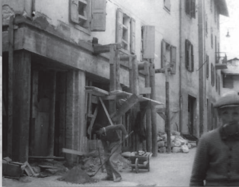
Lavori nella sede, metà anni '60
