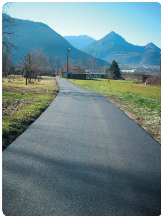
Strada in loc. Ensegua
