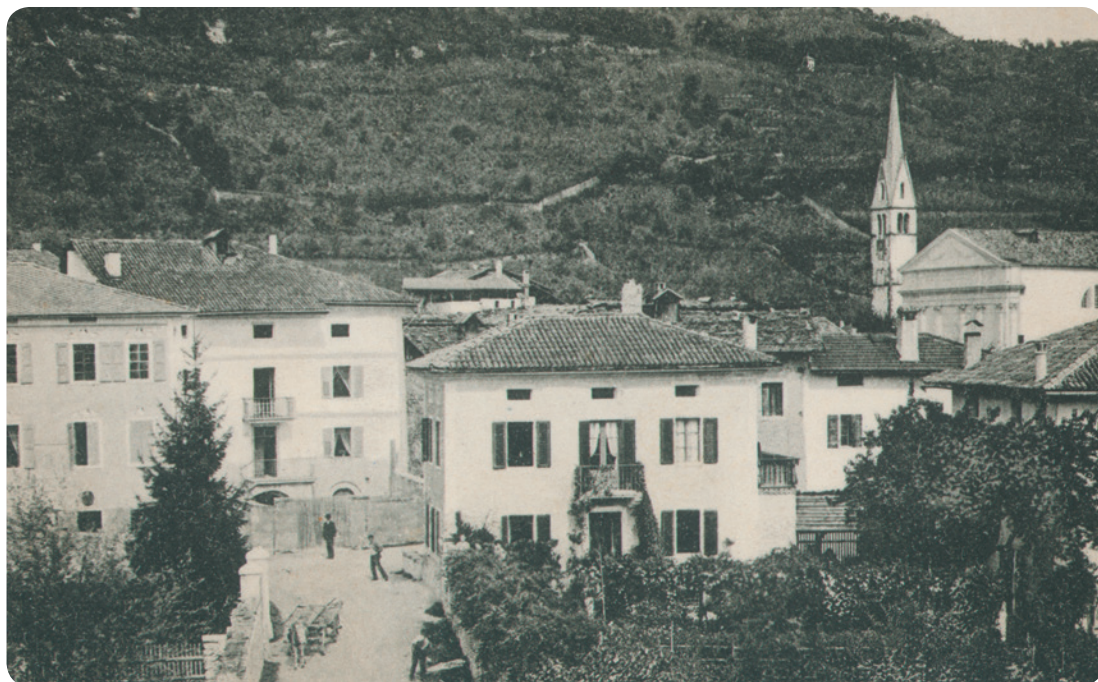
Piazzetta della Posta, inizi del '900
