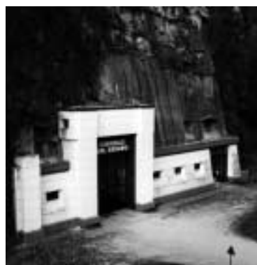
Centrale di Grigno
