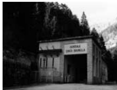
Centrale Costa Brunella
