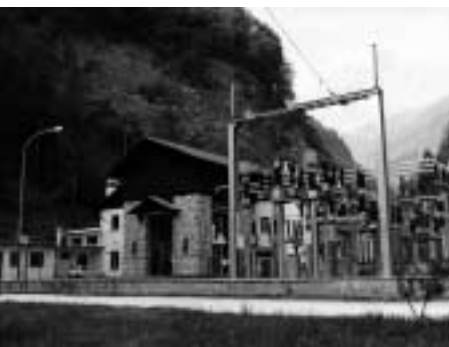
Centrale di Carzano
